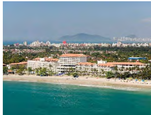
Centro de convenções interno e externo do Hotel Jequitimar, com 6.000m², estacionamento com 500 vagas e manobrista no local.
