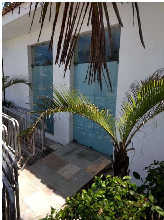
Figura 9 Entrada público - VIP
